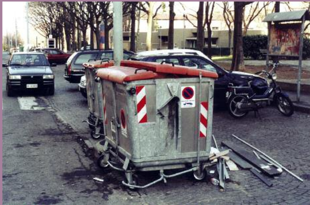
1. Mancanza di coordinamento degli elementi che compongono l'immagine urbana, ingenuità di progetto e di esecuzione, incuria ed abusi, condizionano l'accesso al giardino su via Savigno, prima dei lavori
