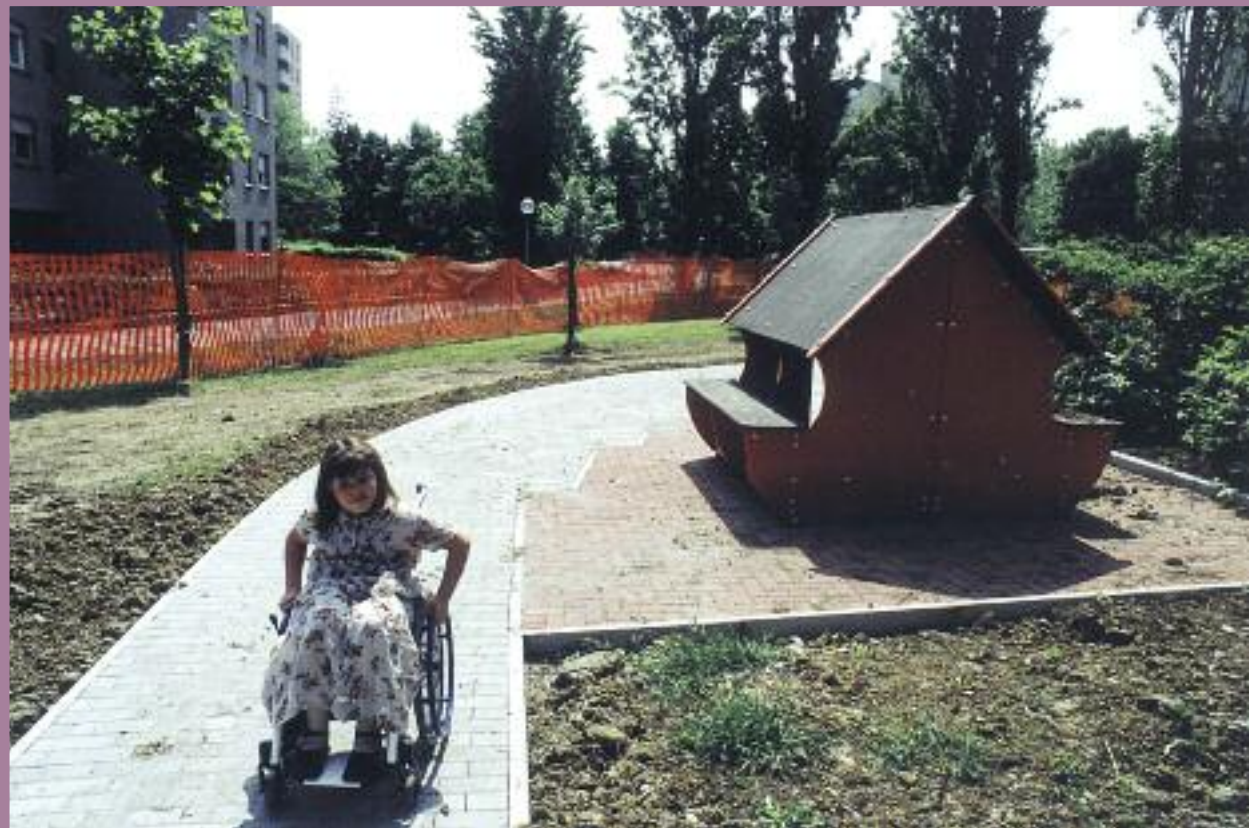
12. L'area della struttura 'negozio' a lavori pressoché ultimati
