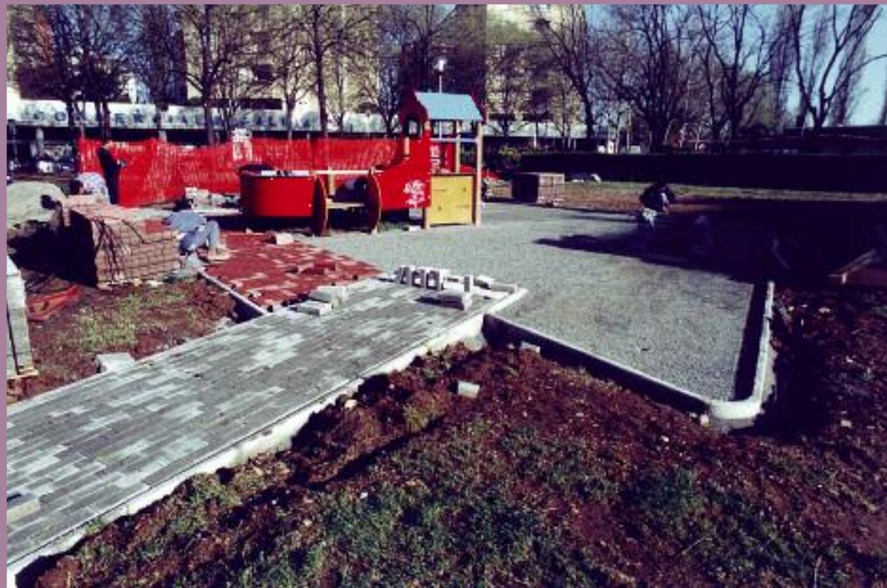
14. Verifica allineamenti, prova installazione giochi e campionatura posa pavimentazioni
