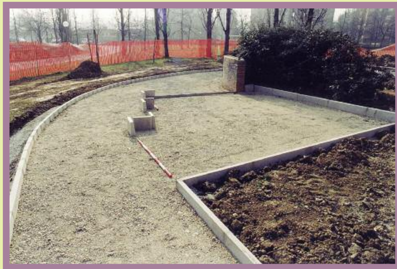
11. La preparazione dei percorsi e delle nuove aree giochi con preparazione dei fondi, tracciamento percorsi e delimitazioni stacchi di pavimentazioni
