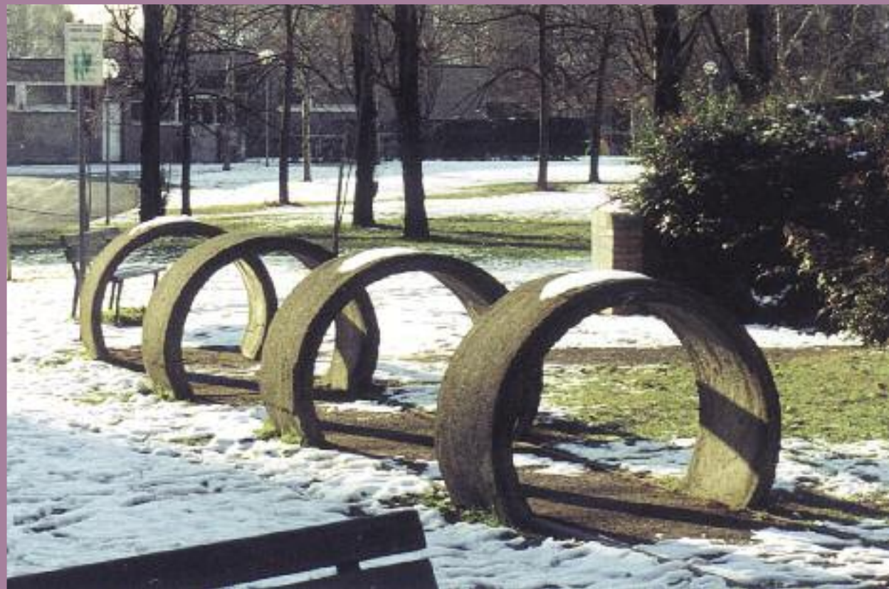
10. Vecchie strutture-gioco abbandonate all'interno del giardino prima dei lavori
