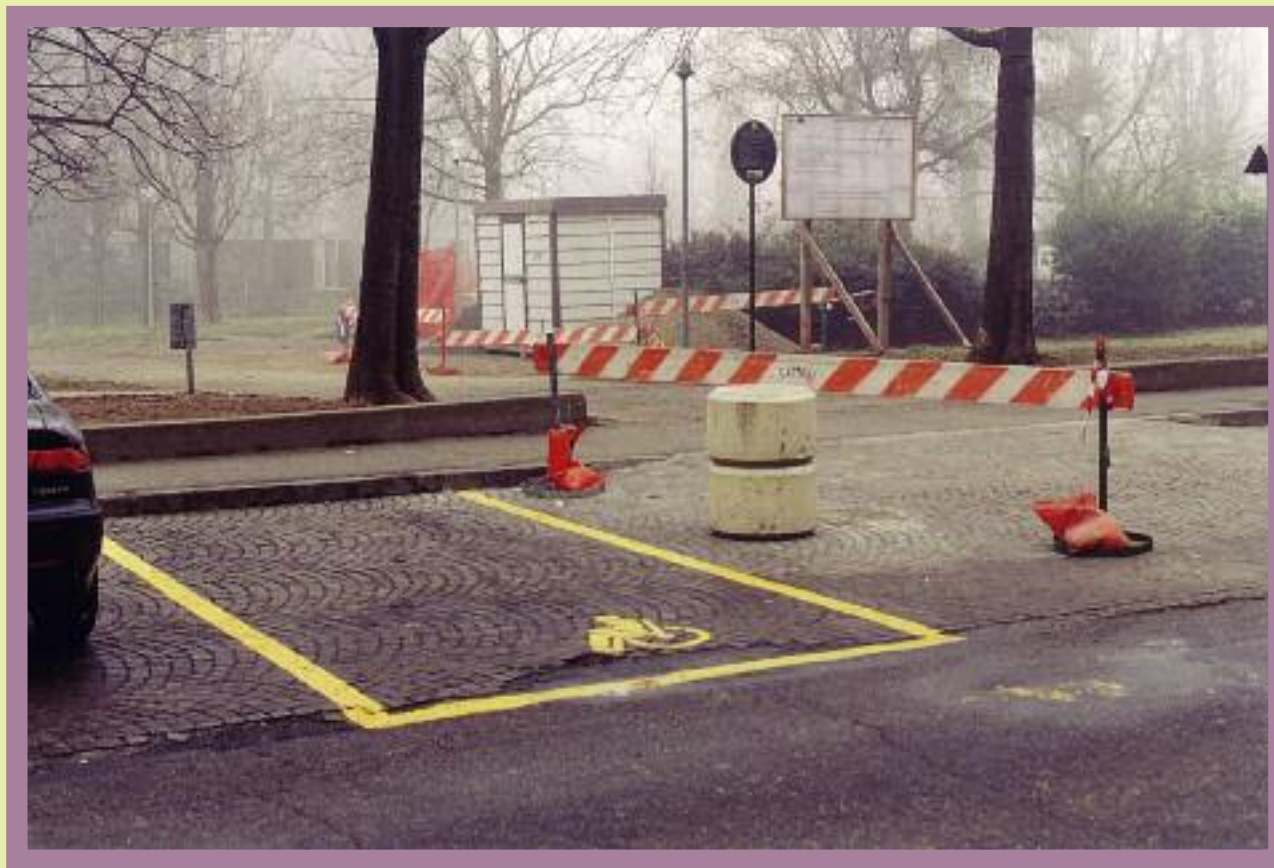
3. Soluzione di accesso con dissuasori di sosta (in fase di collocazione), rampa di raccordo della pavimentazione in porfido e posti auto riservati
